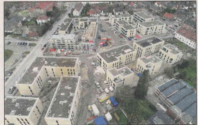
Das Projekt „Wohnen am Kirmesplatz“ aus der Luft betrachtet. Zum Juni dieses Jahres werden 111 von insgesamt 160 Wohnungen bezugsfertig sein. Foto: Wohnungsverein
